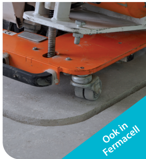
Albrand zorgt ervoor dat de sleuven voor de leidingen snel en stofarm worden ingeslepen in de cementdekuloer.
