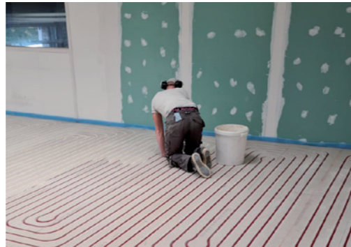
Montage buis met dichtsmere sleuven
