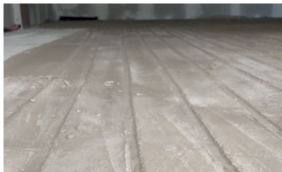
Gefixeerde leiding, vloer nog af te werken door derde partij
