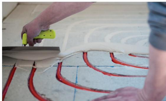
Fixeren leidingsleuven met Knauf Uniflott
