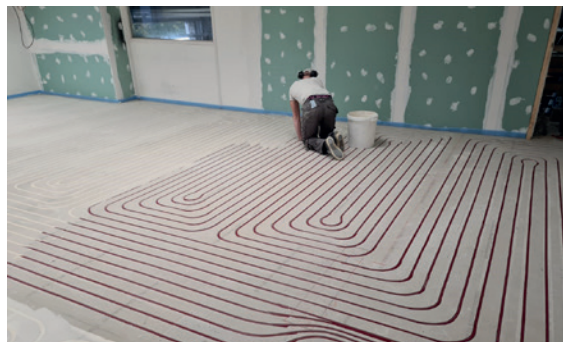
Montage buis met dichtsmen sleuven
